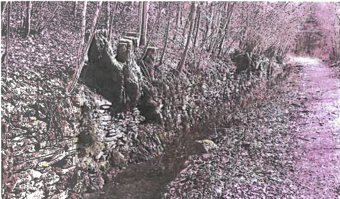
*Abb. 3 Obergraben mit hangseitiger Trockenmauer zur Hangsicherung.*
