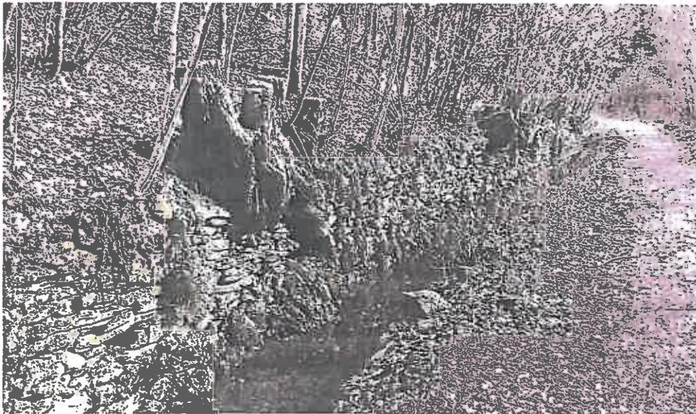
Obergraben mit hangseitiger Trockenmauer zur Hangsicherung.
