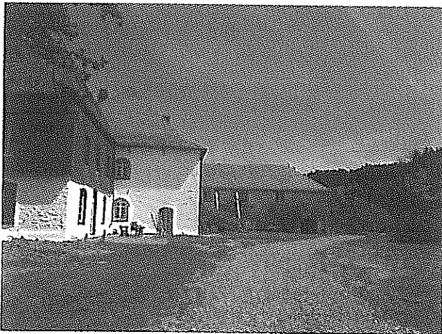
8. Historische Grünfläche auf dem südlichen Teil des Plateaus: ehemaliger Nutzgarten, als Rasenfläche erhalten.
