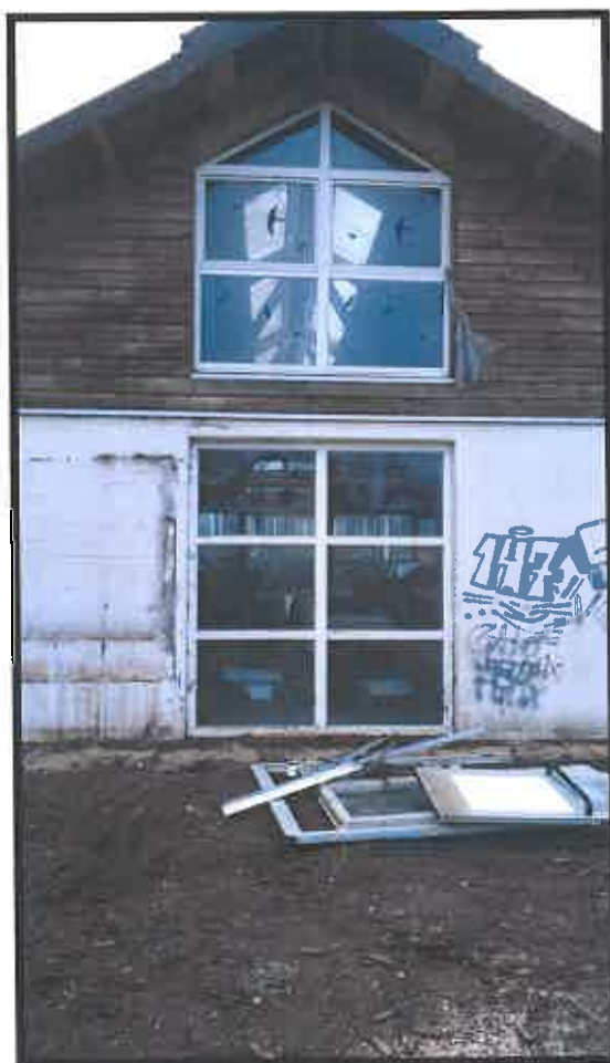
Detail- und Gesamtansicht Südfassade Holzverkleidung ohne rückwärtige Wand o.ä.
