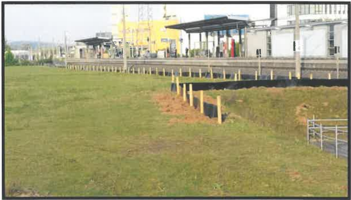
Abb.: Beispiel Amphibien / Reptilienschutzzaun – hier HDPE Platten 2mm – extrem hoher Eignungsnachweis auch für Amphibien
