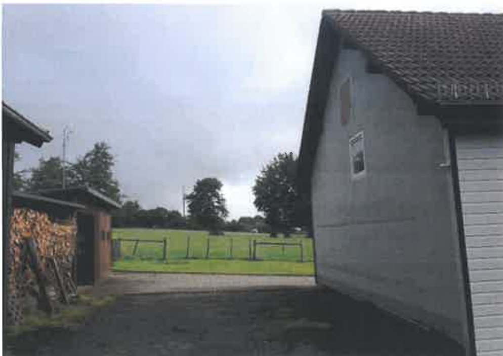
Nördlicher Gebäudeabschluss Stall
