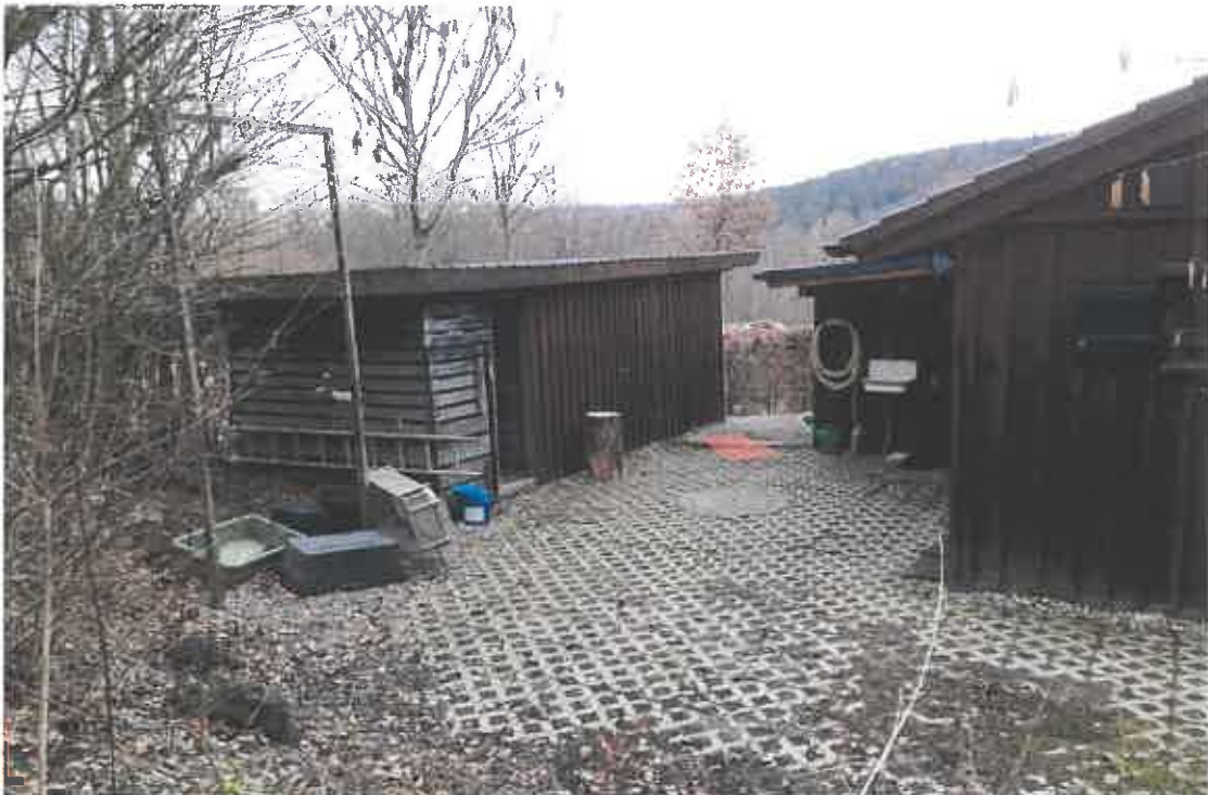
Nördliche Nebengebäude an Jagdhütte (Quelle: KRINGS, ARCHITEKTUR+STADTPLANUNG)
