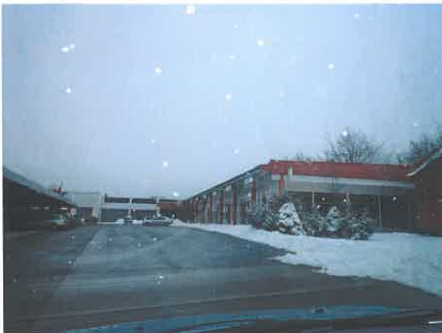
Abbildung 4 Foto Gebäude ehem. Teppichmarkt / SB-Markt
