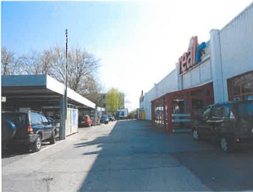
Abbildung 3 Foto Gebäude SB-Markt, Eingang
