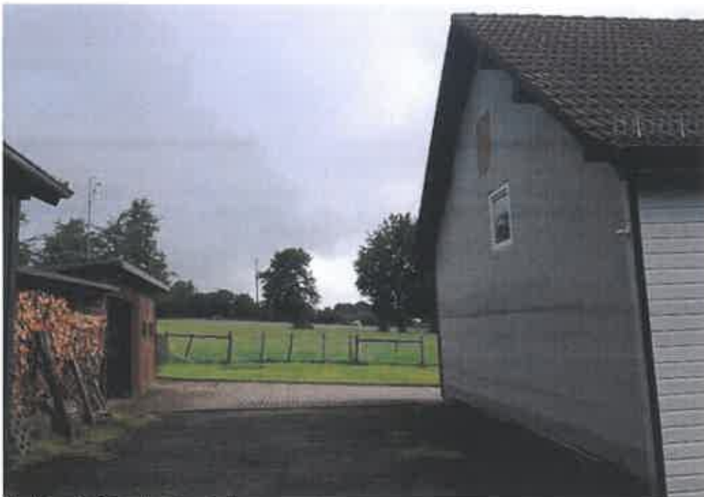
Nördlicher Gebäudeabschluss Stall
