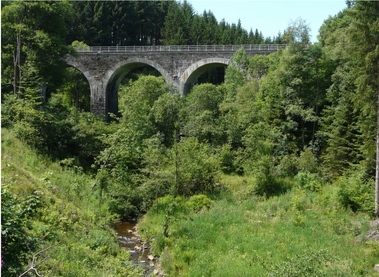
Der Viadukt galt lange als eines der Wunderwerke der Vennbahnstrecke. (Foto: Bernd Läufer)
